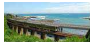
山生(やもめ)橋梁(イメージ)
